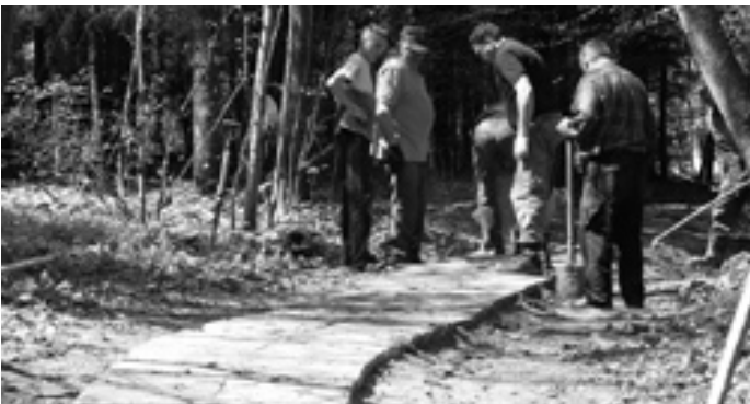
Mieszkańcy Helusza zwieźli płytki i ułożyli chodniki pomiędzy stacjami.
