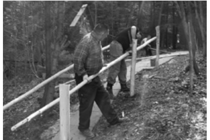
Mieszkańcy Helusza na trudnych podejściach wykonali też ochronne barierki. Całością prac kierował p. Zygmunt Jasilek.
