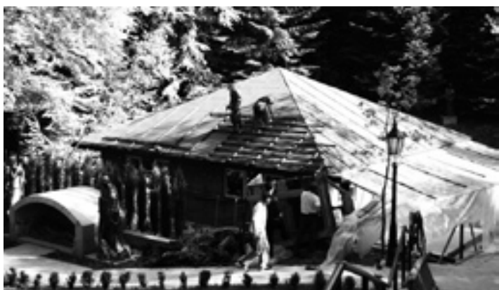
Sala konferencyjna otrzyma nowy dach, nowe tynki i nowy fronton.
