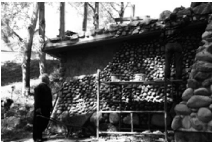
Ściana zewnętrzna grotty zostanie obmurowana kamieniem.
